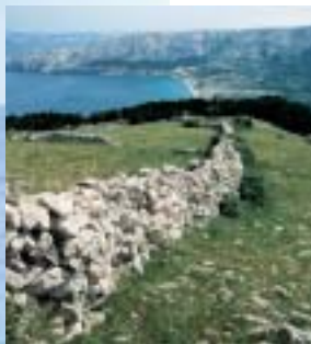
TROCKENMAUERWERK/MURO A SECCO
